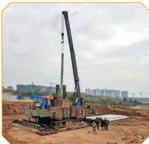
桩基施工现场
