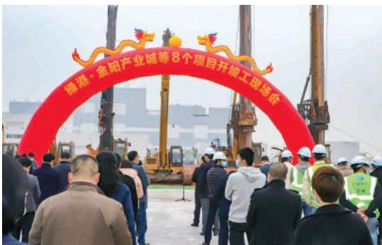
开竣工现场会
